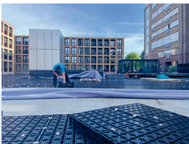
Over het gehele dak zijn kratten geplaatst.
