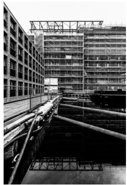
2019 Bouw ondergrondse parkeer- garage (photo Corentin Haubrage) _P6A7821 190514 - 1600x2400-2
