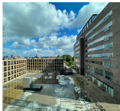
2022 Start aanleg tuin
