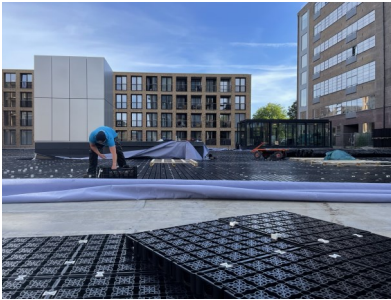
2023 De Meelfabriek Tuin - krattensysteem aanleg
