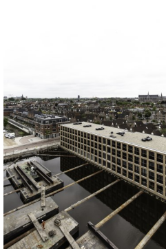
2019 Bouw ondergrondse parkeer- garage (photo Corentin Haubrage) _P6A7871 190514 - 1600x2400
