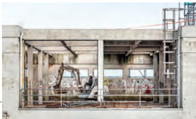
Start sloop Silotoren
