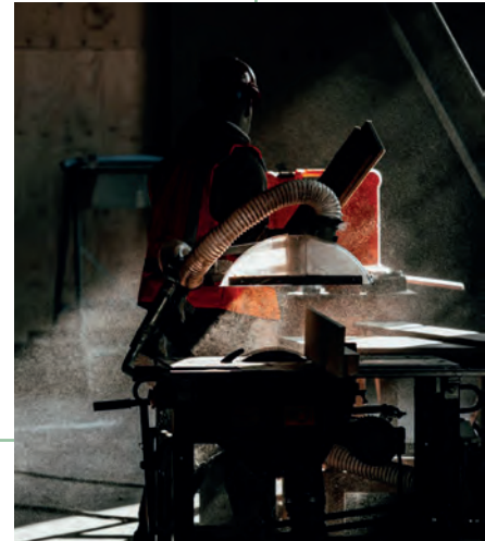
Doorwerken op de bouw tijdens covid
