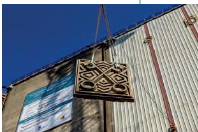
Sleutelpanelen omlaag takelen
