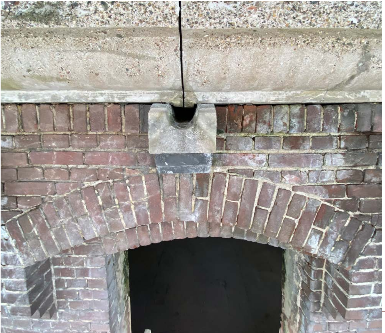
Bovenaan de gevel is de oude daklijst te zien met sierhemelwaternuten
