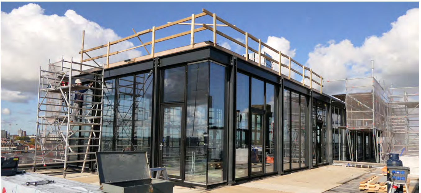
Onder: Beglazing wordt aangebracht in stalen constructie van het penthouse.
