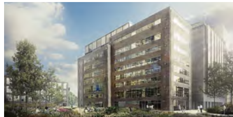
Links: Boven op het Molengebouw en Riffellokaal komt een penthouse.
