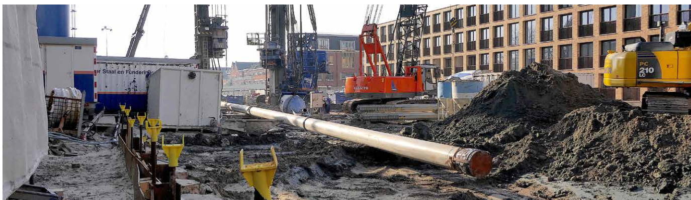
Heiwerkzaamheden voor parkeerkelder van De Meelfabriek
