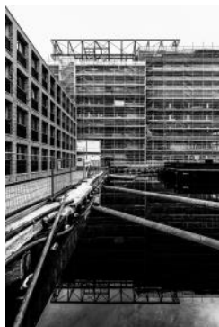
2019 Bouw ondergrondse parkeergarage (photo Corentin Haubruge) _P6A7821 190514 - 1600x2400-2
