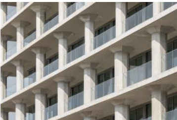
2024 Meelpakhuis gevel (Corentin Haubruge) 240607 10h09 - SAA - MF P35 - R52 0019 - 3600
