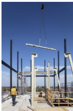
2019 Bouw optopping Molengebouw-Riffellokaal (photo Corentin Haubruge) _P6A4127 - 1200x1800
