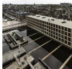
2019 Bouw ondergrondse parkeergarage (photo Corentin Haubruge) _P6A7871 190514 - 1600x2400
