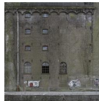
2025 Start werkzaamheden Ketelhuis (photo Corentin Haubruge) 250306 SAA - MF P36 - 0393 - 5K
