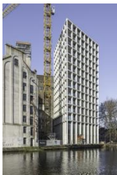
2025 Silotoren (Corentin Haubruge) 250306 SAA - MF P36 - 0043 - 5K
