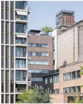
2023 De Meelfabriek mix van monumentaal en nieuwbouw (photo Corentin Haubruge) 230531 SAA - MF P33 - 1059 - 5k
