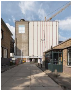
2025 Hotelgevel (Corentin Haubruge) 250820 SAA - MF P37 - 0194 - 5K
